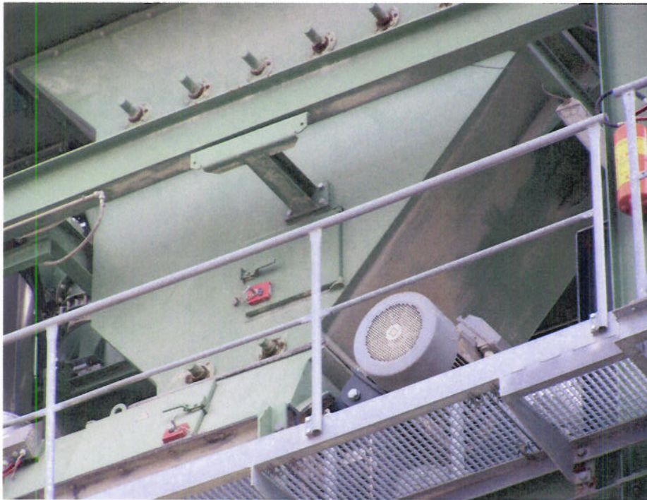
Izgled vage za agregat i način oslanjanja na MPS u slučaju bez polužnog sistema
