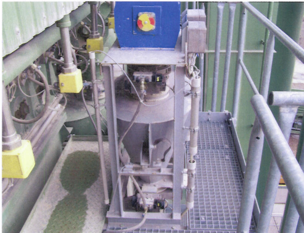
Izgled vage za dodatke i način oslanjanja na MPS u slučaju bez polužnog sistema
